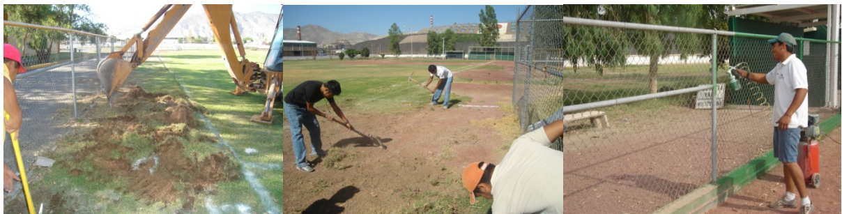
Fig. 50 Mantenimiento al campo de Beis bol
