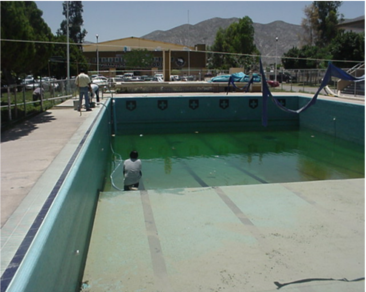
Fig.48 Mantenimiento de la Alberca
